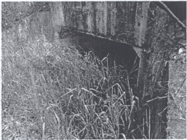
Cống hộp lý trình Km108+684 Khẩu độ 2.0x1.5m
