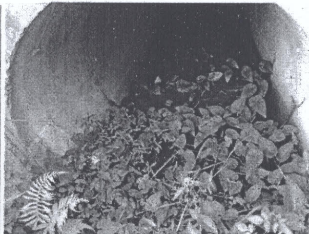
Cống tròn lý trình Km102+860 đường kính D1.5m
