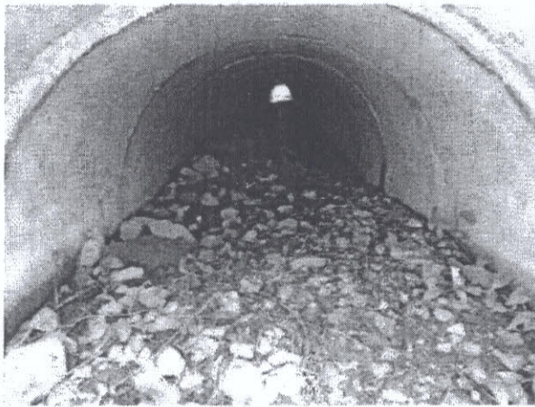
Cống tròn lý trình Km108+276 đường kính D1.5m
