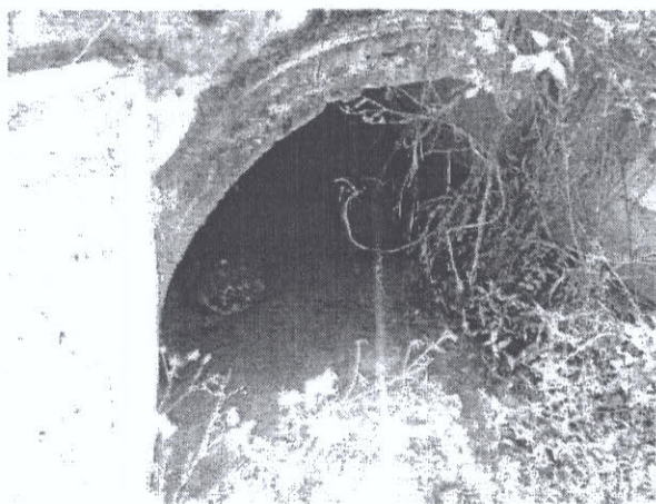
Cống tròn lý trình Km108+610 đường kính D1.5m
