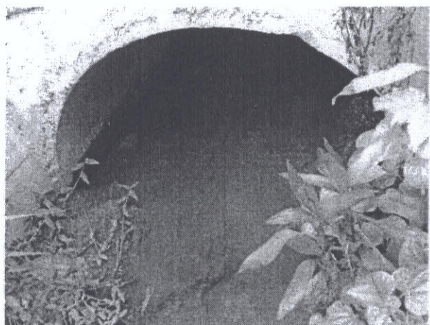
Cống tròn lý trình Km102+516.5 đường kính D1.5m
