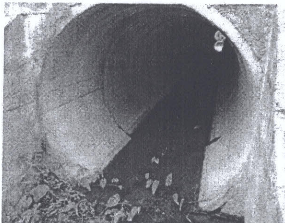
Cống tròn lý trình Km101+034 đường kính D1.5m
